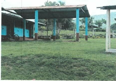
Foto 2: Muro perimetral frente al edificio escolar
