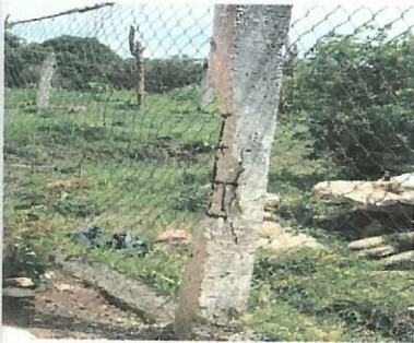
Foto1: Raparación del muro perimetral
