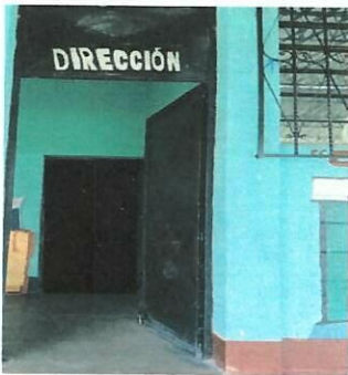
Reparación de piso de la dirección
