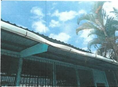
Foto 4: Reparación de canales de agua pluvial
